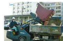
積み込み作業中
