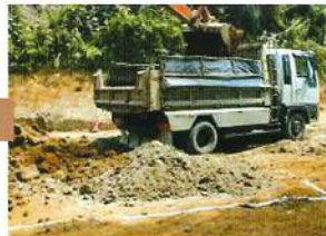
積み込み搬出作業
