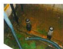
汚泥吸引後のタンク
