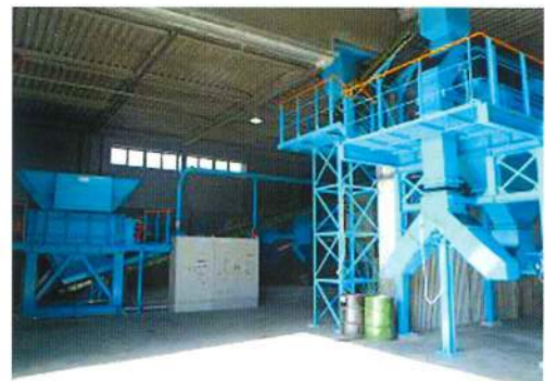
二軸破碎機全景
