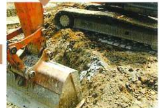
重機で吸着固化作業
