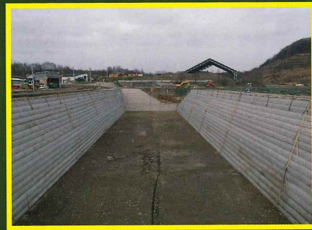
第一レーン内部
