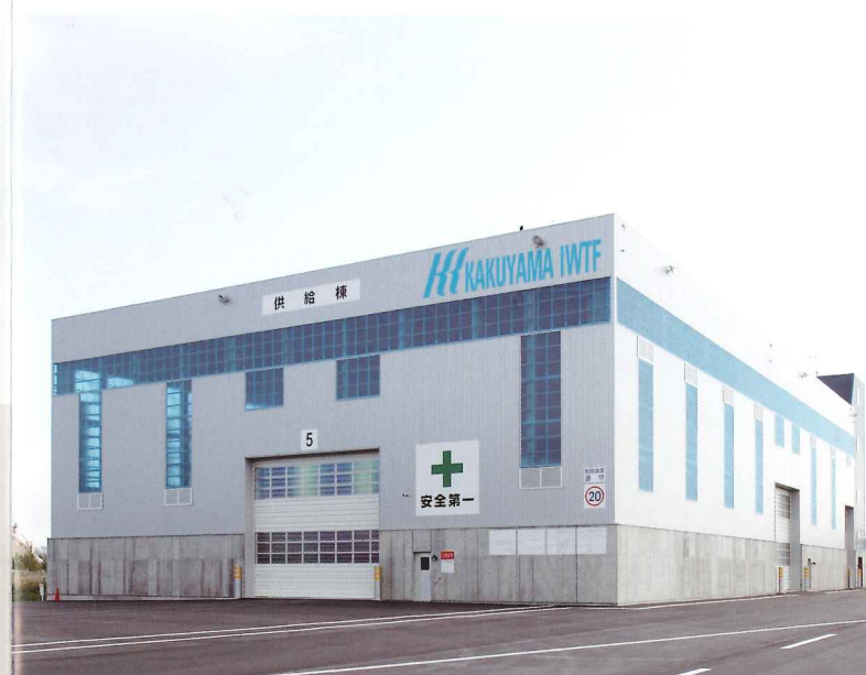
④ 廃棄物受入施設／供給棟 供給棟内で廃棄物の受入保管を行うことで飛散防止を図ります。
