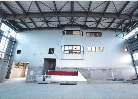
17 中央監視室 焼却施設の稼働状況・設定確認を行い、各モニターで施設の監視を行います。
