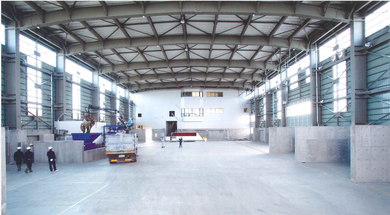
7 供給棟プラットフォーム
