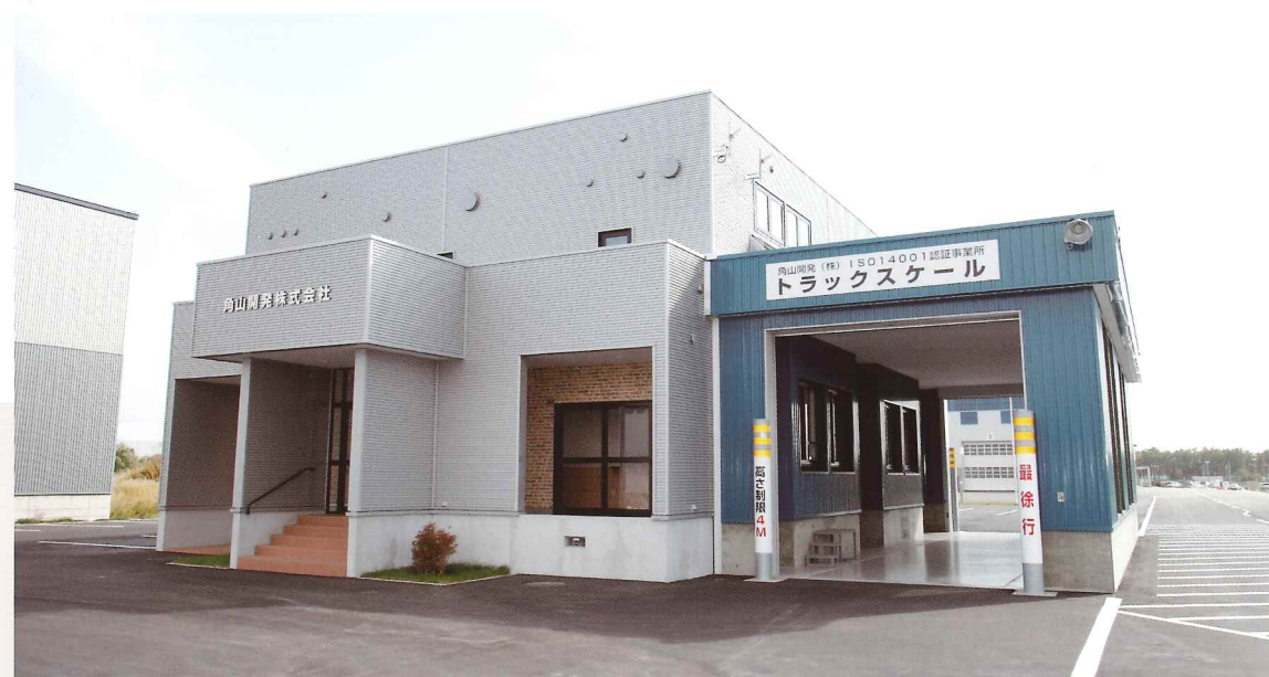
① 本社事務所・管理棟 搬入車両の受付を行います。
